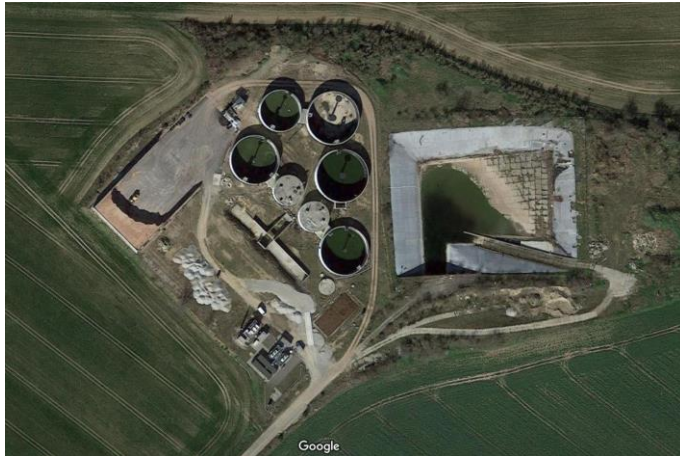
Bild 5: Biogaseinspeiseanlage in Gordemitz vor Neustart des Projekts. Bild: Google Maps Stand 25.06.2021
