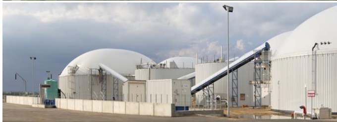
Bild 1 bis 4: Biogaseinspeiseanlage in Gordemitz bei Inbetriebnahme. Bild: Schmack Biogas Service GmbH und UTS Products GmbH
