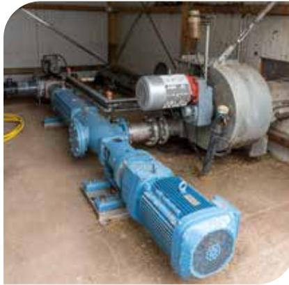
Eine Exzentrerschneckenpumpe drückt die in der Mixbox mit Rezirkulat angemischten Feststoffe in den Fermenter.
