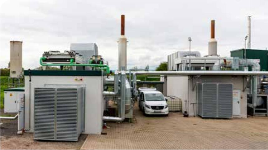
Ein Teil des Rohbiogases dient als Kraftstoff für zwei Jenbacher-Blockheizkraftwerke mit einer elektrischen Leistung von 1.200 beziehungsweise 1.500 Kilowatt.
