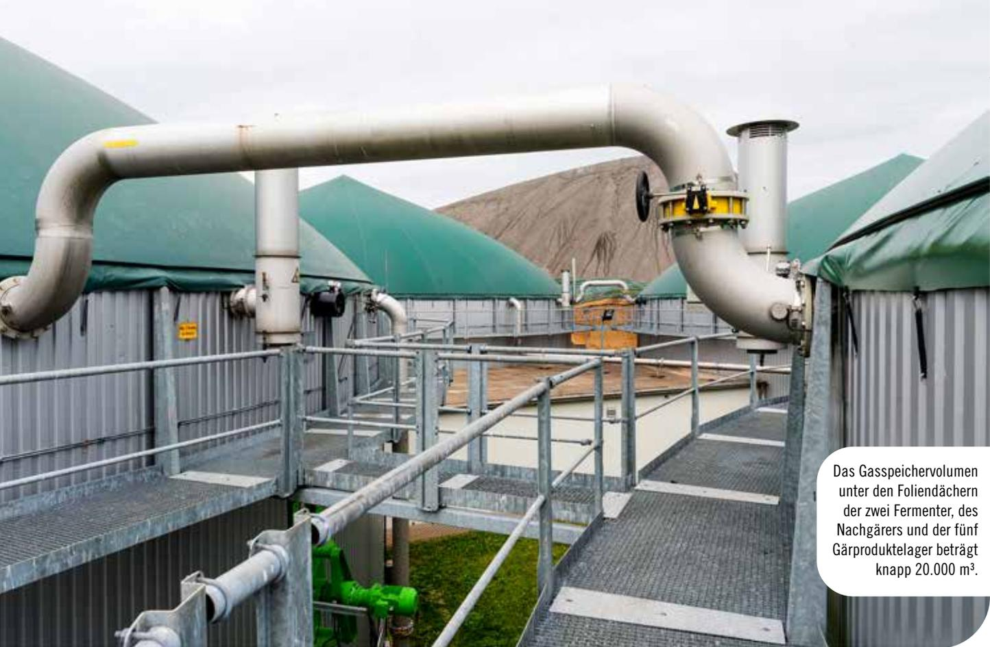
Das Gasspeichervolumen unter den Foliendächern der zwei Fermenter, des Nachgärs und der fünf Gärproduktelager beträgt knapp 20.000 m<sup>3</sup>.
