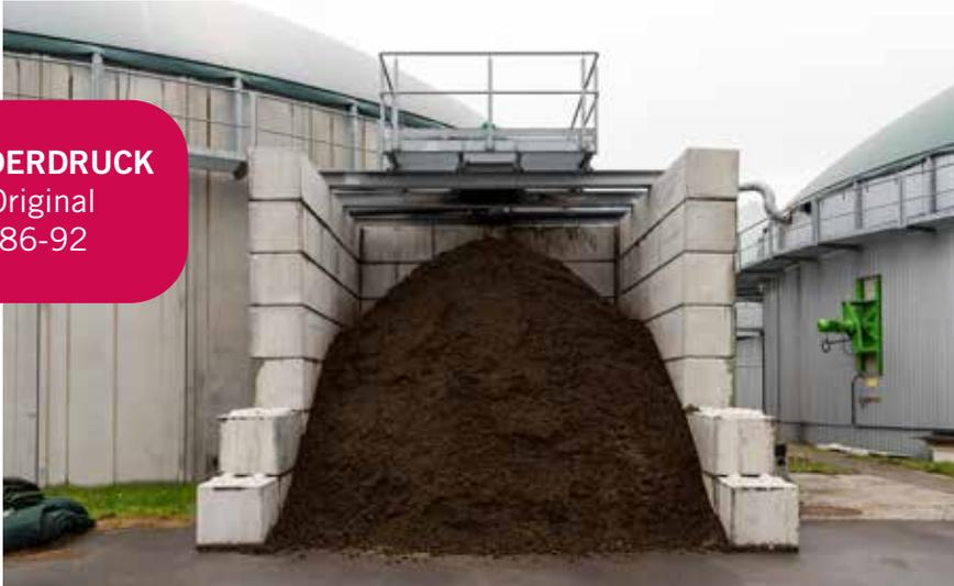
Beim Verlassen des beheizten Gärproduktelagers wird der gesamte Stoffstrom separiert und die flüssige Fraktion in die vier kalten Gärproduktebehälter geleitet.
