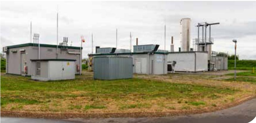
55 bis 60 Prozent des produzierten Rohbiogases werden zu Biomethan aufbereitet und ins Gasnetz eingespeist.
