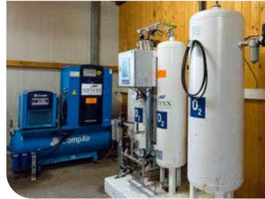
Die Entschwefelung des Rohbiogases erfolgt durch Zugabe von selbst erzeugtem reinen Sauerstoff.
