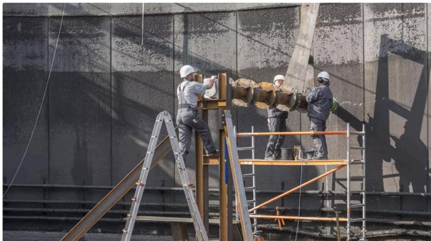
Einbau der Paddelrührwerke: Sie sind an der Fermenterwand und am Boden gelagert. (Bildquelle: Kanadevia Inova Schmack)
